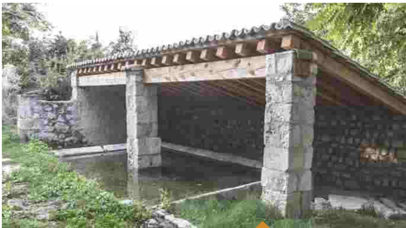
Imagen del lavadero de Balconete tras la restauración
